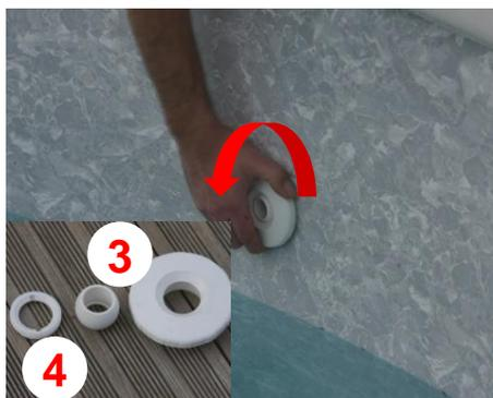
Retirez la rotule orientable ③ et la partie centrale ④ de la buse de refoulement.
