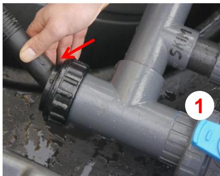
Ouvrez la vanne d'aspiration ① et terminez la vidange de la tuyauterie dans le Locatec.
