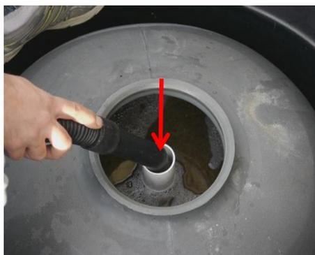
Vidangez l'eau située dans le filtre, par le tube central, avec un aspirateur à eau.
