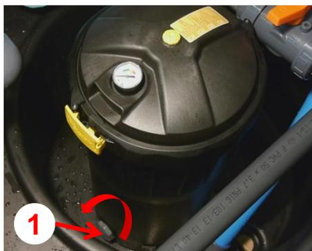
Retirez le bouchon de vidange ① situé à la base du filtre afin de le vider totalement.
