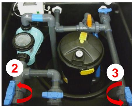
Ouvrez la vanne d'aspiration ② et la vanne de refoulement ③.
