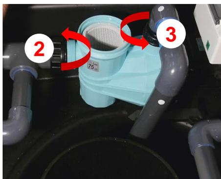
Dévissez le raccord d'entrée ② et le raccord de sortie ③ de la pompe.
