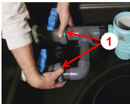
Retirez une partie de la tuyauterie ① afin de pouvoir déposer la pompe.
