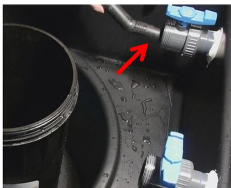
Terminez la vidange de la tuyauterie dans le Locatec via la vanne de refoulement.
