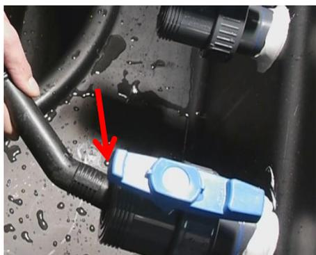
Terminez la vidange de la tuyauterie dans le Locatec via la vanne d'aspiration.
