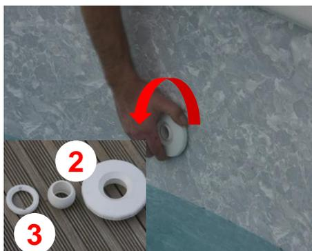
Retirez la rotule orientable ② et la partie centrale ③ de la buse de refoulement.
