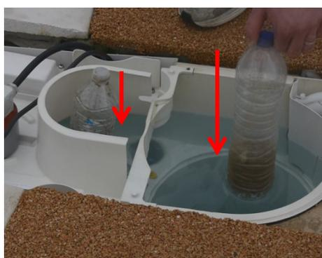
Placez une bouteille d'eau lestée de sable dans le col et le corps du Filwat CS.
