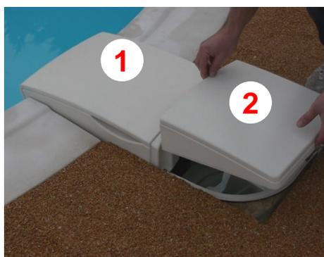
Remettez en place le couvercle de la pompe ① et le couvercle du filtre ②.
