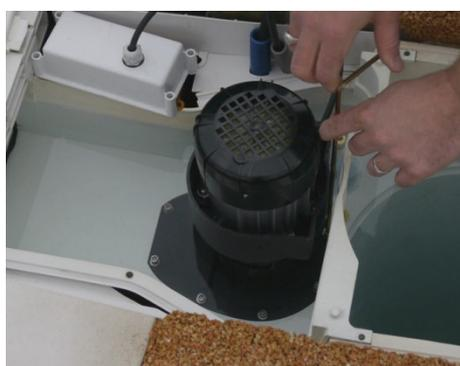
Dévissez les 8 vis de fixation de la pompe FCS à l'aide de la clé 6 pans.
