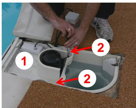
Déposez la platine ① en dévissant les 2 vis ② .
