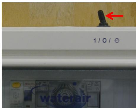
Mettez l'interrupteur de la filtration sur la position 1.
