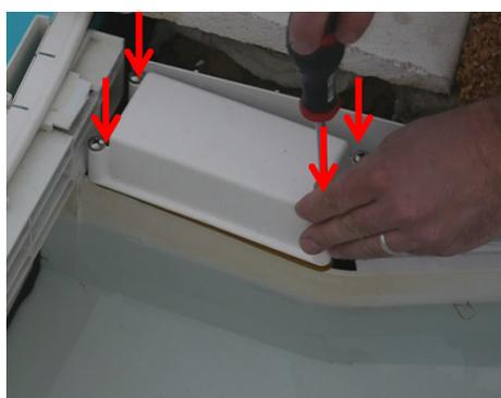
Fixer le capot d'hivernage du boîtier de connexion avec les 4 vis.
