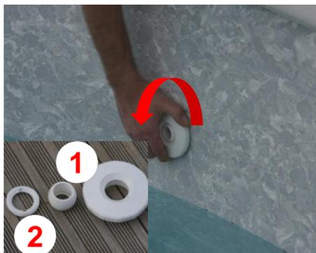
Retirez la rotule orientable ① et la partie centrale ② de la buse de refoulement.
