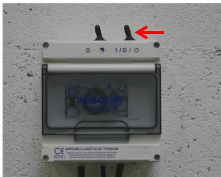
Mettez l'interrupteur de la filtration sur la position 1 jusqu'à ce que l'eau soit claire dans le témoin du filtre à sable (pendant environ 2 minutes).
