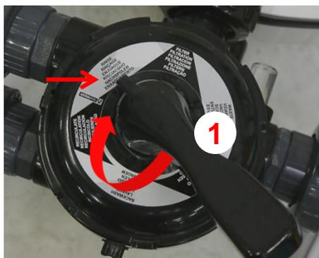
Placez la vanne multivoies ① sur la position RINÇAGE.
