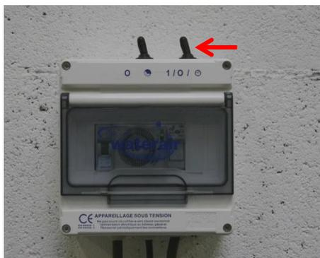
Mettez l'interrupteur de la filtration sur la position 1 jusqu'à ce que l'eau soit claire dans le témoin du filtre à sable (pendant environ 1 minutes).
