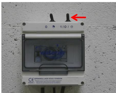
Arrêtez la filtration en plaçant l'interrupteur sur 0.
